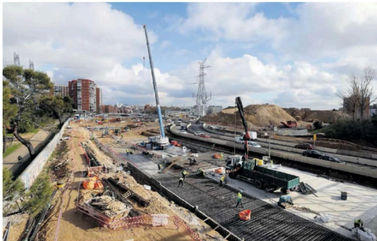
Un grupo de operarios trabajaba en las obras de soterramiento de la autovía A-5 en Madrid, el 14 de enero. JAIME VILLANUEVA
